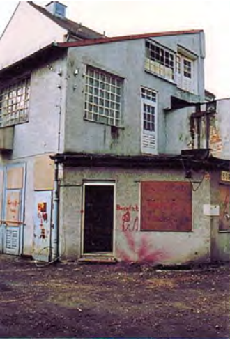
Reste der Werkstätten im Hof. Aus ihnen entstehen die Stadthäuser.
